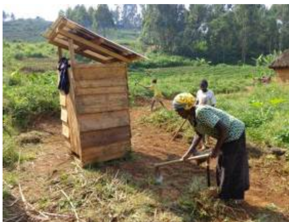
Une nouvelle latrine familiale modèle hygiénique construite Entretenue par les utilisateurs
