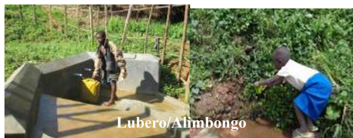
Une source aménagée par PPSSP La source jadis utilisée par les bénéficiaires
